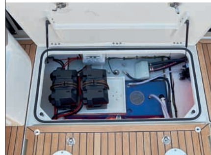
Stauraum unter dem Cockpit-Boden
